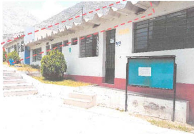
Coberturas con canalón de asbesto – cemento
