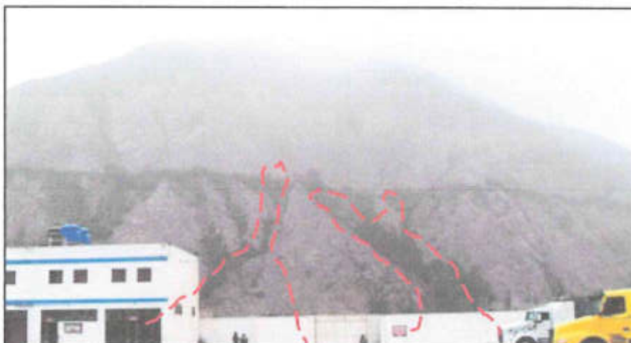
Derrumbes y caída de rocas en las inmediaciones de la Urb. Batasol, margen izquierda del río Rimac.
