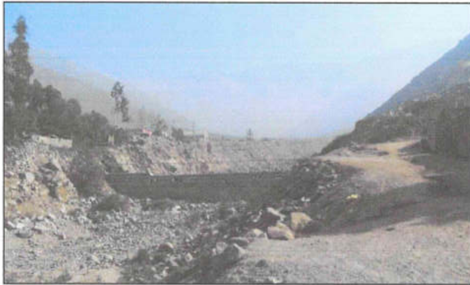
Quebrada Quirio. Muros de contención para retención de sólido a fin de evitar que los flujos de arenitos alcancen la parte baja de la quebrada (Carretera Central), donde se encuentra la mayor parte de la población.
